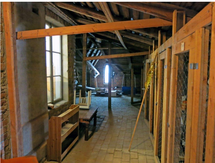
Kylmän ullakkotilan lattia on ladottu tiilistä. Ullakolle on rakennettu kevytrakenteisia varastokoppeja.
