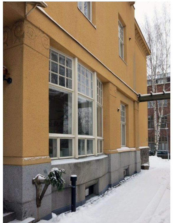
Oleskeluhallin eteläosan erkkerimäinen ikkuna.
