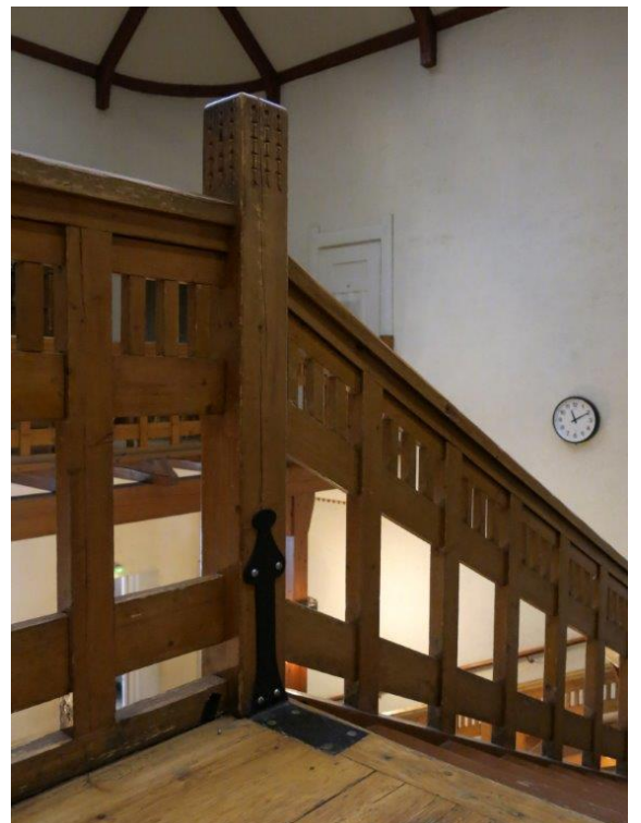
Ylähallin (201) puukaiteet ja niiden takorautaiset kiinnikkeet ovat rakennusaikaiset.
