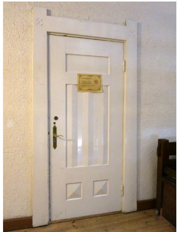
Asuinhuoneiden ja komerojen vällovet lukkoineen, kahvoineen ja kehyslistoineen ovat alkuperäisiä.
